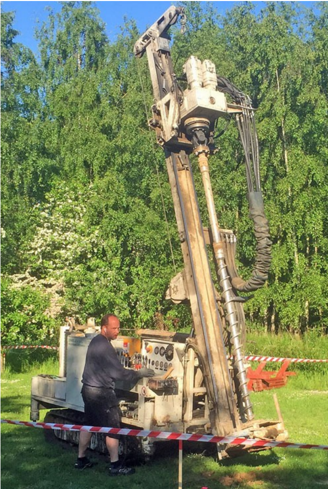
Geoteknikkeren i arbejde
